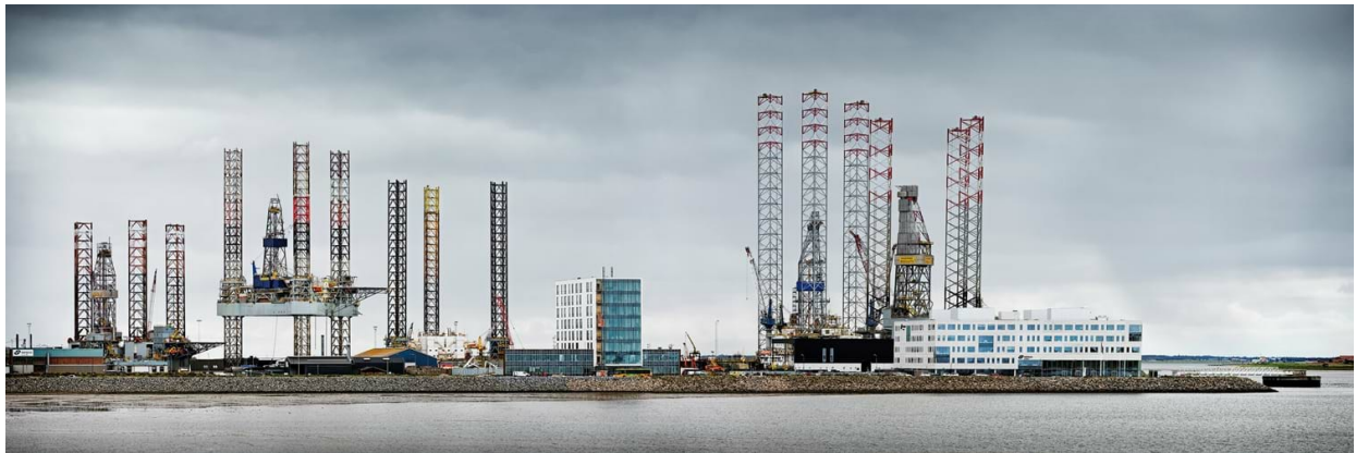
Borerigge på den eksisterende havn. Foto: Esbjerg Havn
