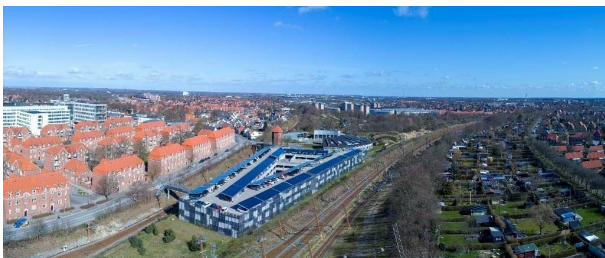
Luffoto af det eksisterende parkeringshus og området.
