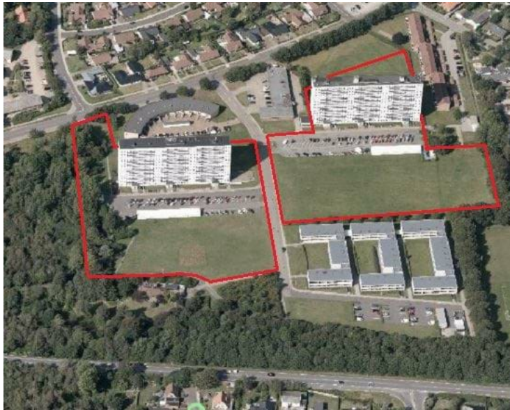
Skråfoto af eksisterende forhold fra øst mod vest SDFE.
