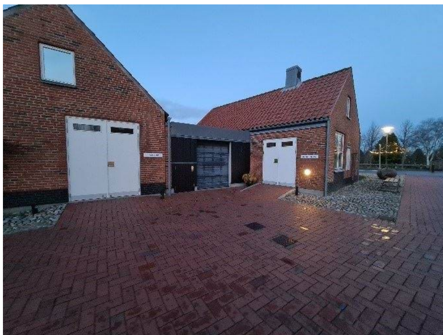
Eksisterende tekniske bygninger med adgang til porte fra Damvej.
