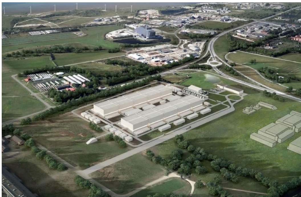
Figur 3-1. Principiel oversigt over placering af de forskellige bygninger og anlæg i lokalplanområdet.
