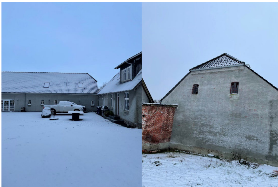
Figur 3-67 Nybygget slagterbutik og stuehus, på bagsiden er ituslåede vinduer.
