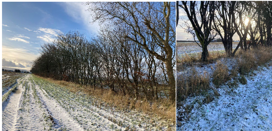
Figur 3-45 Fotos af diget fra besigtigelsen.
