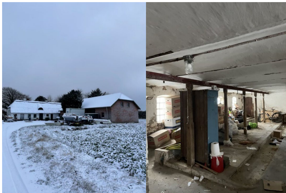
Figur 3-66 T.v. stuehus og staldbygning set fra nord mod syd. T.h. staldbygningen anvendes til opbevaring.
