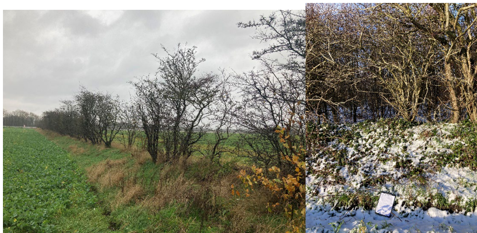
Figur 3-46 Fotos af diget fra besigtigelsen. T.v. spredte hvidtjørn på diget, t.h. weatherwriter der illustrerer højden af diget, her ca. 1,2m højt.
