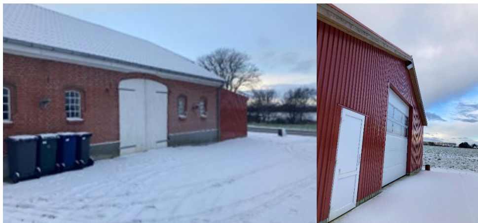
Figur 4-24 Maskinhal (t.h.), samt og ladebygning (t.v.).
