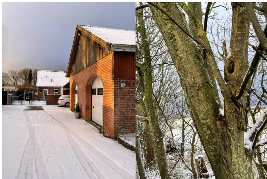
Figur 3-72 Th. Stuehus, samt garage ombygget til hundekennel. T.v. seljerøn med hulhed der ikke er egnet for flagermus.
