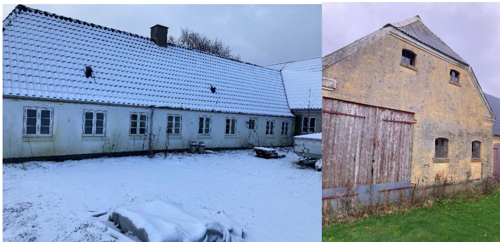
Figur 4-23 Beboelseshuset (t.v.) samt ladebygning (t.h.).
