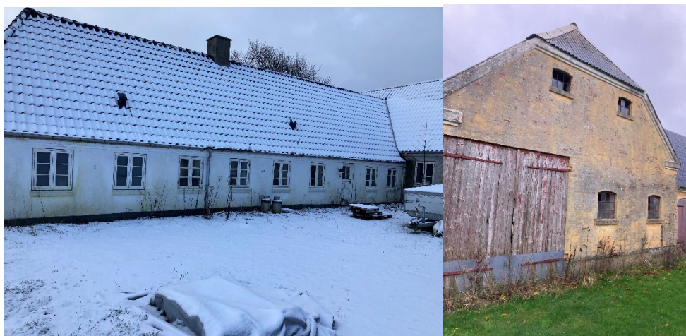
Figur 3-56 Fotos af bygningerne, t.v. beboelsen og t.h. lade/udbygning.
