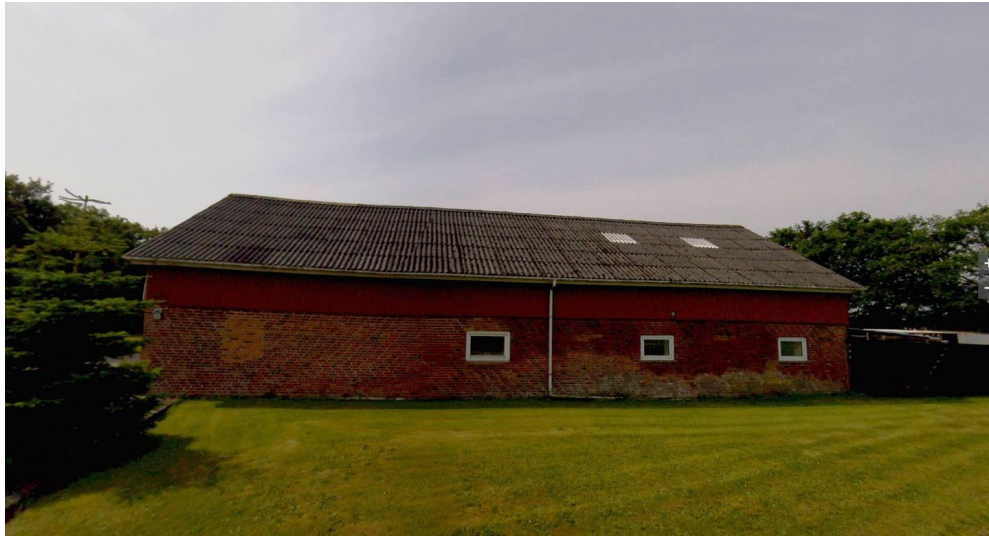
Figur 7-1 Vestre Lufthavnsvej 15. COWI Gadefoto, 2023
