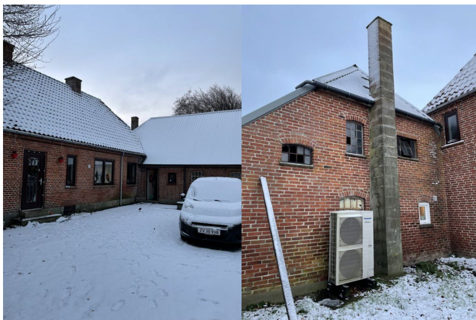
Figur 3-68 Stuehus, samt staldbygning med fyrrerum og ituslåede vinduer.
