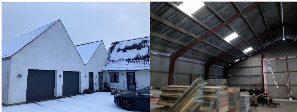
Figur 3-58 Fotos fra besigtigelsen, t.v. huset, t.h. maskinhal.
