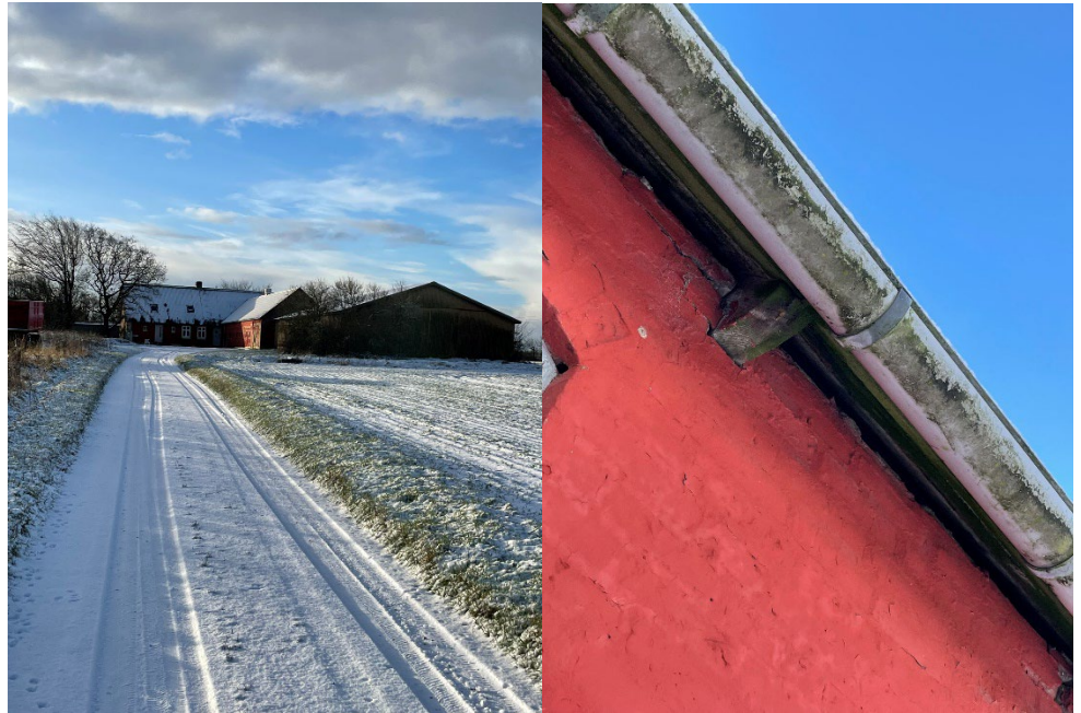
Figur 3-65 Bygningen set fra indkørslen og udhæng set fra øst mod vest.
