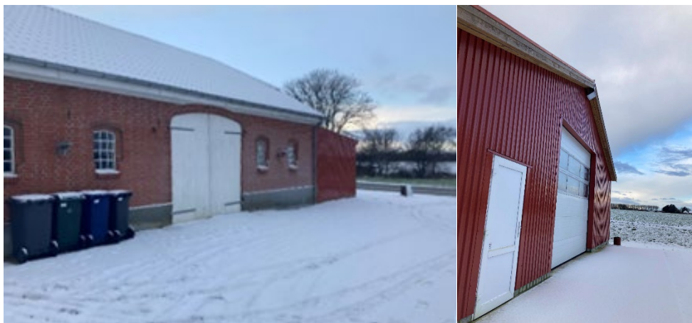
Figur 3-61 Fotos fra besigtigelsen af maskinhal og udbygninger
