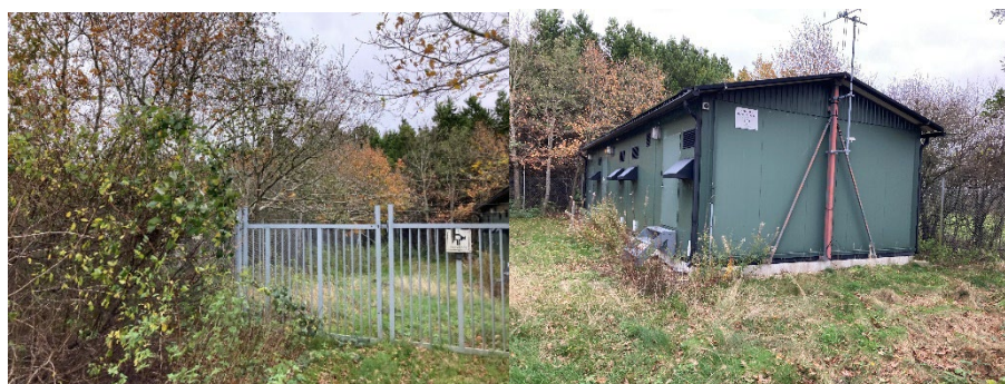
Figur 3-73 Hegnet areal og teknisk anlæg (bygning).
