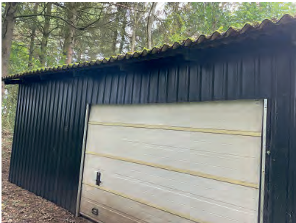
Figur 3-50 Brændeskur og hønsehus beliggende ud mod E58B
