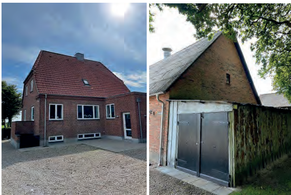
Figur 3-47 Stuehuset (tv), samt garagen med huller og knuste vinduer (th).
