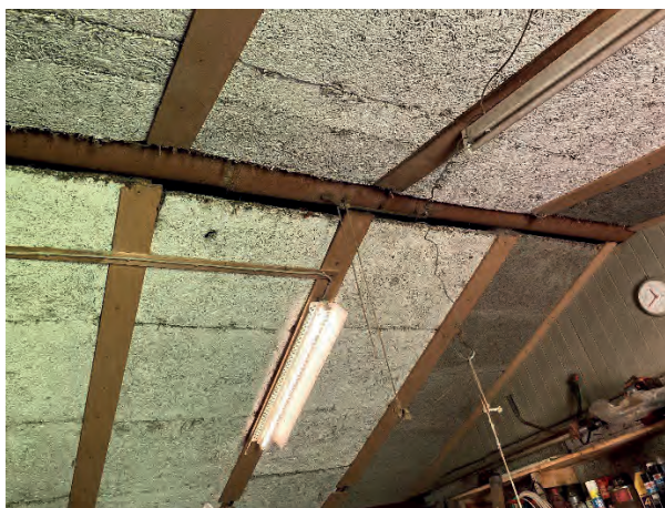
Figur 3-26 Staldbygningen havde flere huller i loft og tagkonstruktion.
