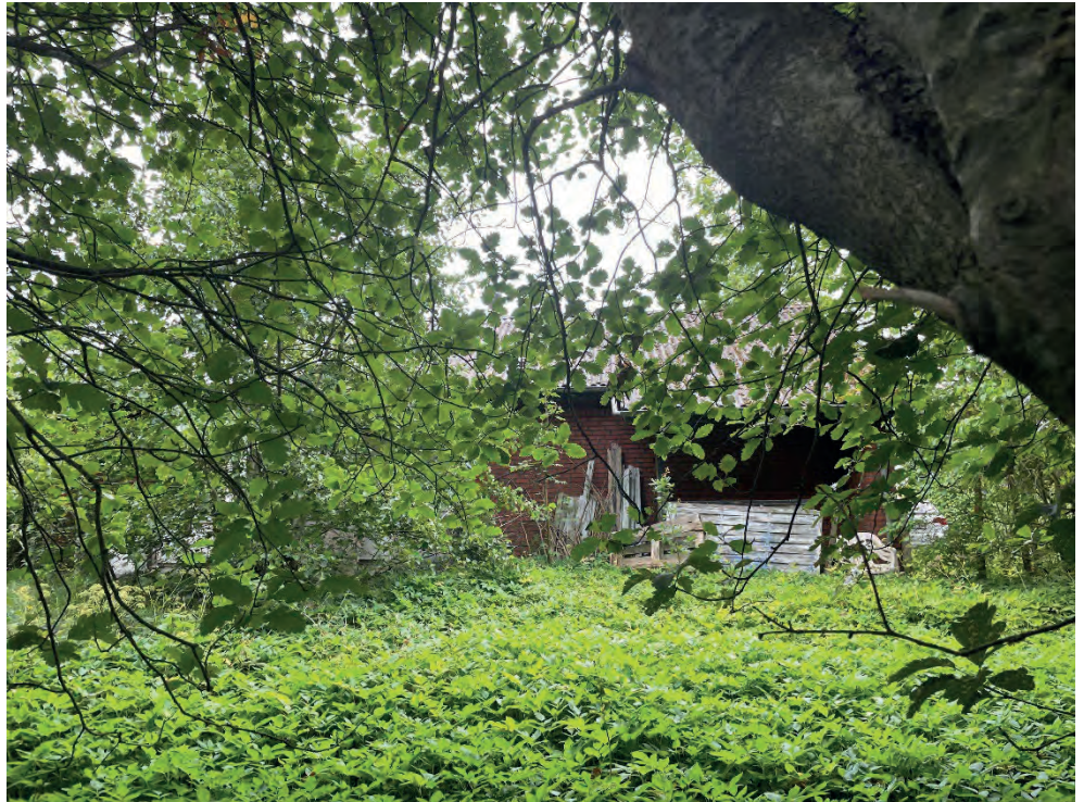
Figur 3-48 Bygningerne er forfaldne og består af et træhus, hønsehus og brændeskur.
