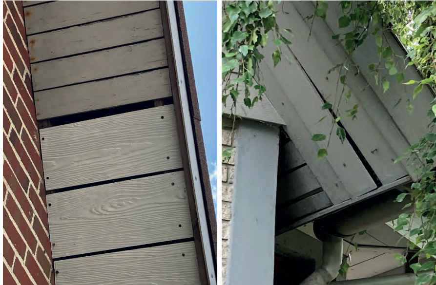
Figur 3-30 Der var løse brædder i østgavlen på E08H
