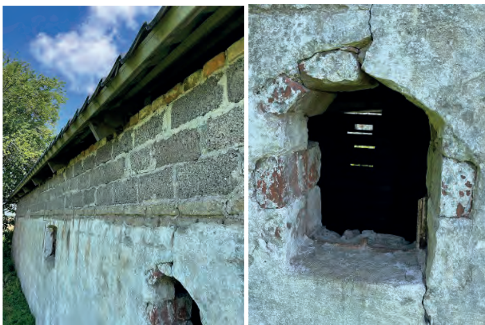
Figur 3-14 Udhus med åbninger i tagkonstruktion og murværk.
