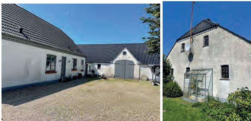
Figur 3-13 Hovedhuset og laden (tv.), samt sydgavlen på hovedhuset (th.)
