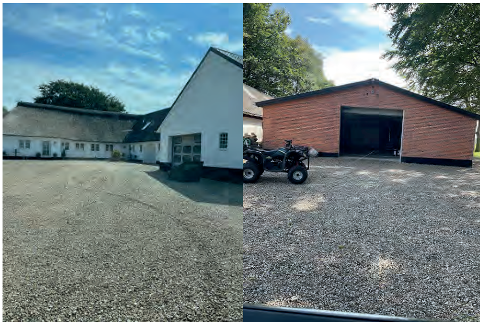
Figur 3-10 Foto tv. viser Stråtægt hovedhus uden adgang for flagermus. Foto taget i retning mod vest. Foto th. viser Garagen bag hovedhuset der er uden vinduer eller loft. Foto er taget i retning mod syd.
